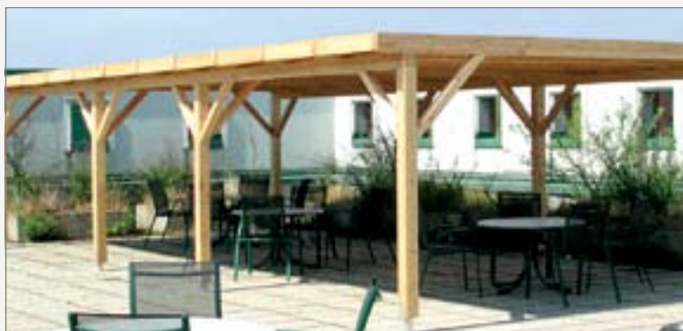
hlavný nosník – pomocný nosník ŠÍKMÝ SPOJ
