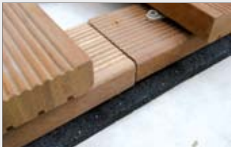
umiestnite protivibračný kobrec pod lištu
